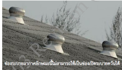
ช่องระบายแบบนี้ไม่ถือว่าเป็นช่องเปิดระบายควัน เนื่องจากไม่สามารถทำงานได้ภายใต้อุณหภูมิสูง
